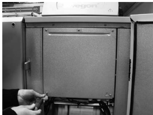
12. Återställ elcentral./ Restore the distribution box.
