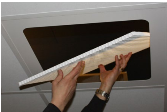
Figure 2. Installation de la grille dans ADAPTER.
