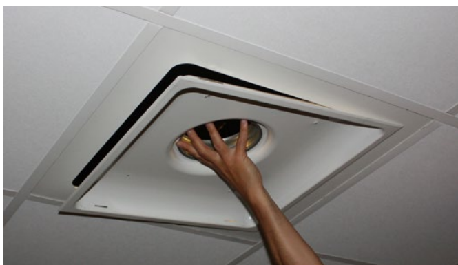
Figur 2. Montering av luftdon under ADAPTER.
