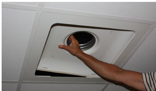
Figur 4. Luftdonet läggs i ADAPTER på samma sätt som en undertaksskiva läggs i bärverk.
