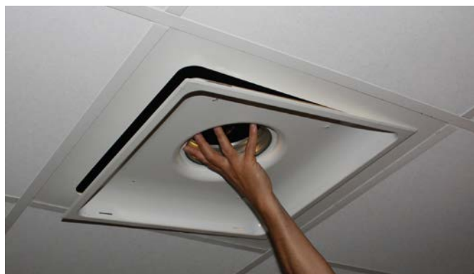
Рис. 2. Монтаж диффузора под ADAPTER
