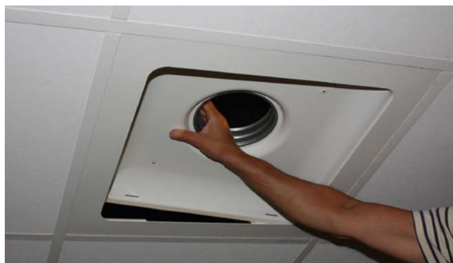
Рис. 4. Диффузор монтируют на ADAPTER, как и потолочные панели
