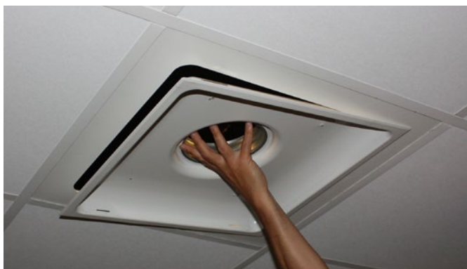
Figure 2. Installation du diffuseur en dessous d'ADAPTER.
