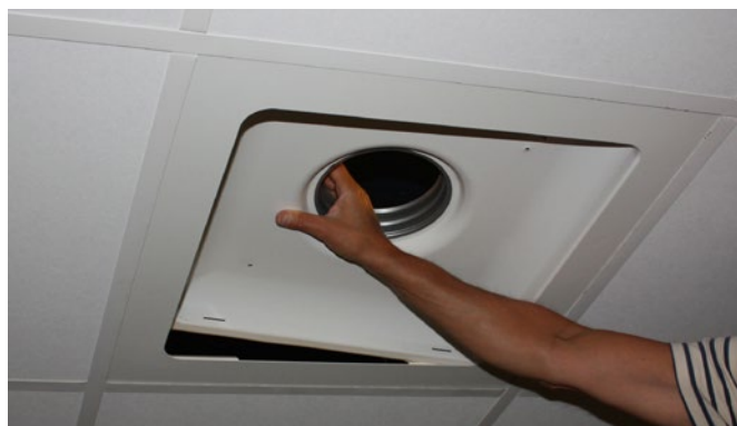
Figure 4. Le diffuseur s'installe dans l'ADAPTER de la même manière que les dalles sont suspendues dans les faux plafonds.
