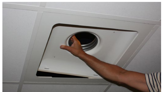
Abb. 4. Der Luftauslass wird in ADAPTER auf dieselbe Weise eingelegt, wie die Zwischendeckenscheibe in den Träger gelegt wird.
