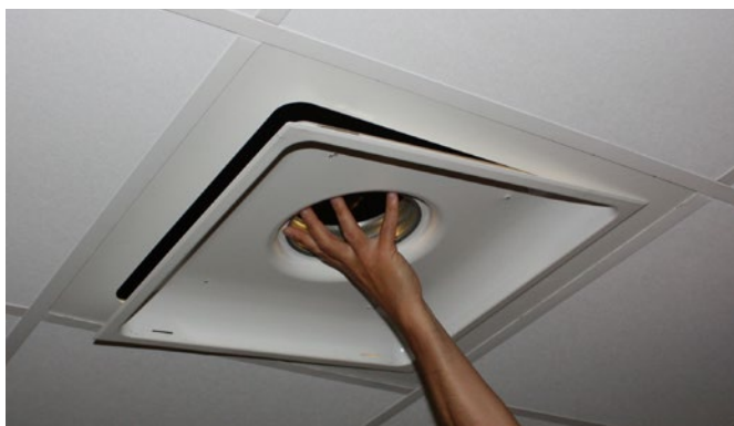
Abb. 2. Montage des Luftauslasses unter ADAPTER.
