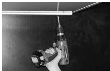
ILTO W80 låses genom höljet i väggmonteringsplattan.
