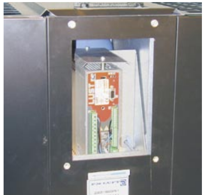
Ohjauslaitteistovaihtoehtoja on useita erilaisia. Taajuusmuuttaja voidaan asentaa puhallinkotelon sisälle kokoluokissa 060 ja 090.
