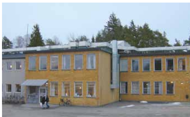
Воздуховоды большого центрального агрегата - дорогие и громоздкие
