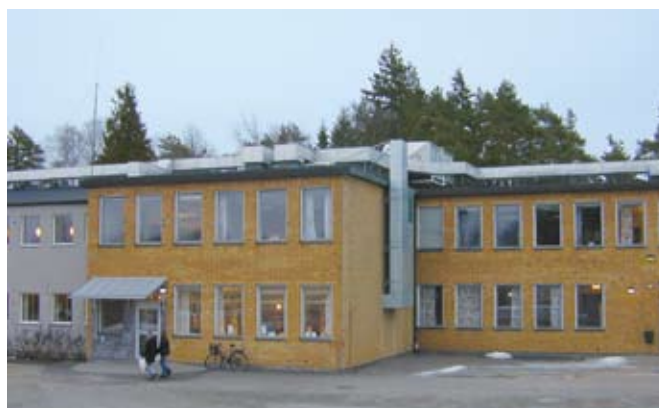
Воздуховоды большого центрального агрегата- дорогие и громоздкие
