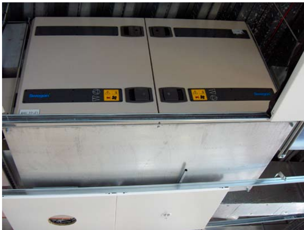
GOLD-агрегат, размещенный в подшивном потолке, освободил полезную площадь пола
